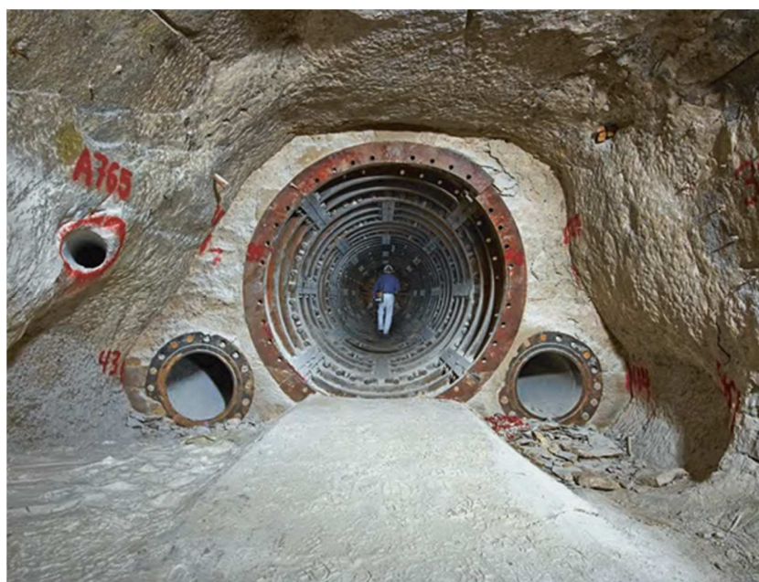
Abb. 19 Foto des Dammjochs auf der 700-m-Sohle der Schachtanlage Asse II, Foto von Janosch Gruschczyk [BfS 2014].
