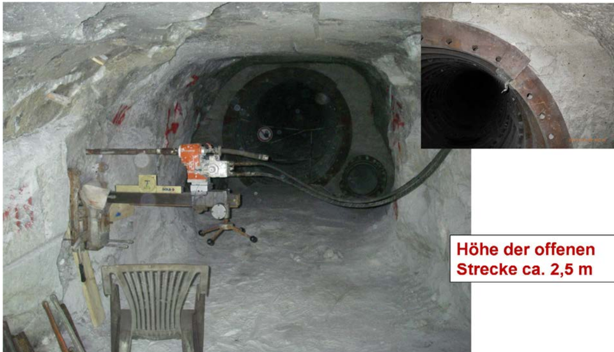
Abb. 3.6-2: Blick auf das Dammjoch von Westen im Jahr 2014 mit gebrochenem, gußeisernem Tübbing auf der 700-m-Sohle in der SchachtanlageASSE II.
