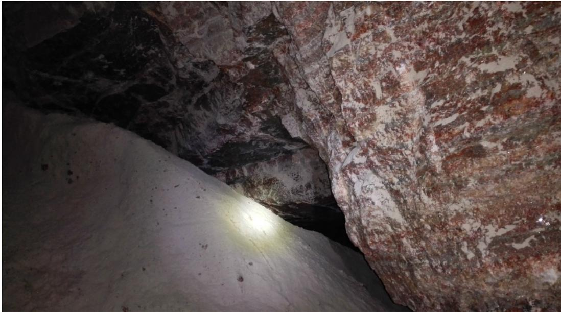
Abbildung 70: Ausbildung eines Firstspaltes nach der Erstverfüllung von Kammern mit angefeuchtetem Salzgrusversatz [Foto: Toni Schmidt]
