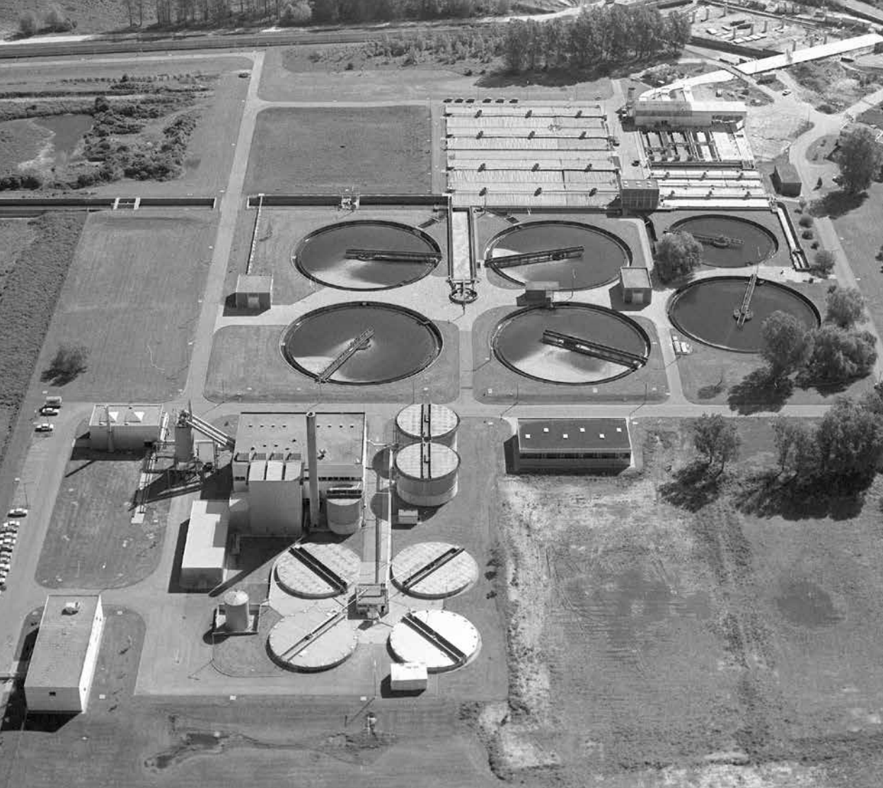
Das Karlsruher Klärwerk 1980. Die biologische Reinigungsstufe wurde 1976 eingeführt, die Denitrifikation folgte 1984 und die Phosphorfällung 1988.
