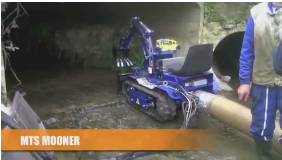
Abb. 1: „Mooner“ mit Tieflöffel und Saugleitung
