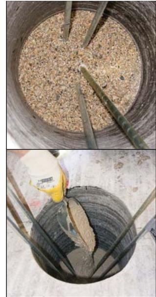
Betonage des Widerlagers mit 80 kg MgO-Beton der Rezeptur C3
