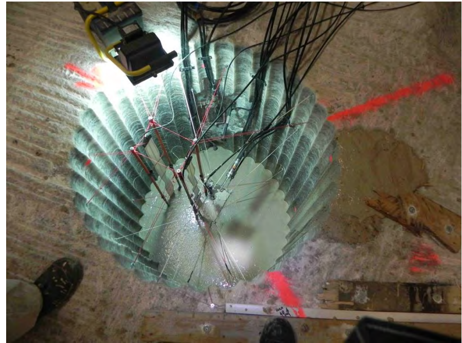
Nach Beginn der Betonage
