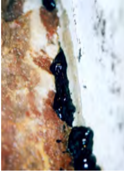
Verpressen der Kontaktzone MgO-Beton - Gebirge
