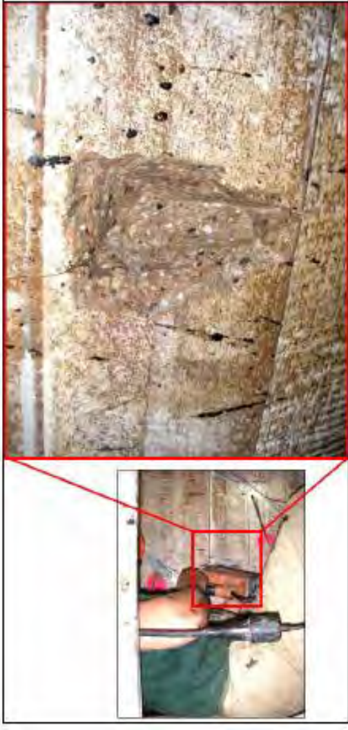
Sichtbare Risstiefe < 5 cm
