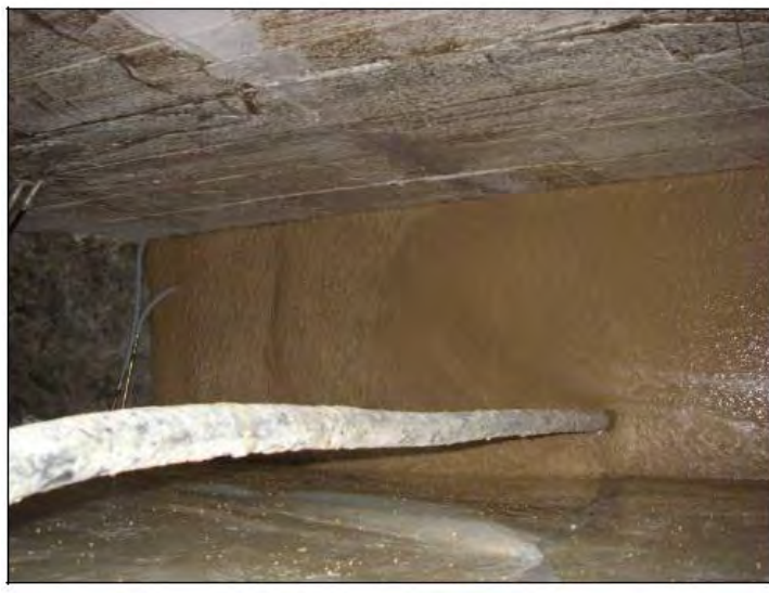
8. Betonierabschnitt (3,5 kg Zuschlag / kg MgO)
