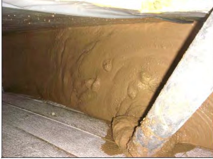
5. Betonierabschnitt (4 kg Zuschlag / kg MgO)
