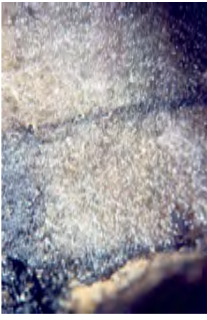
Verpressen der Kontaktzone Mit Injektionsbitumen gefüllter Riss im Salzgestein
