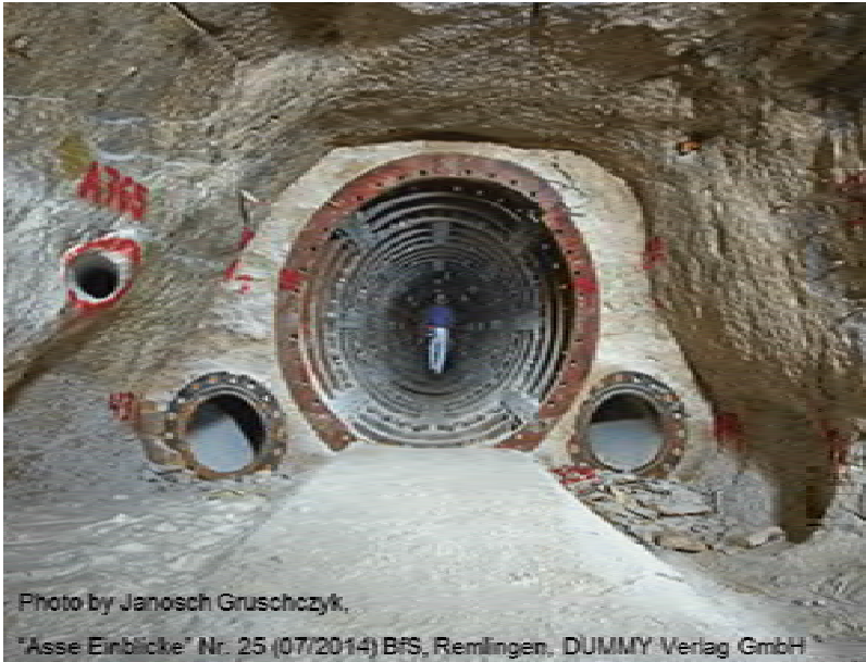
Bulkhead ("Dammjoch", Asse mine)
