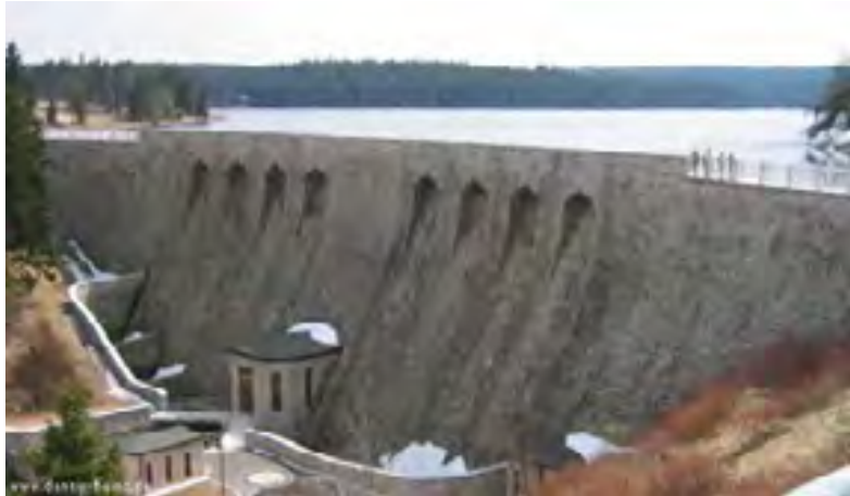
Talsperre Weiterswiese, in Betrieb seit 1930
