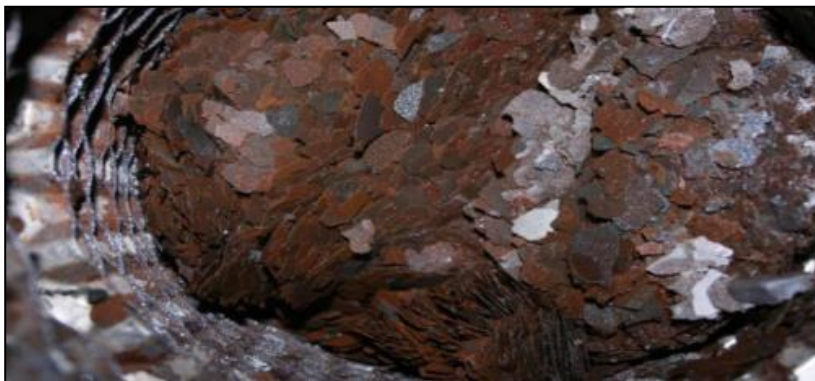
Ablagerung vom Wärmetauscher einer Geothermieranlage.
